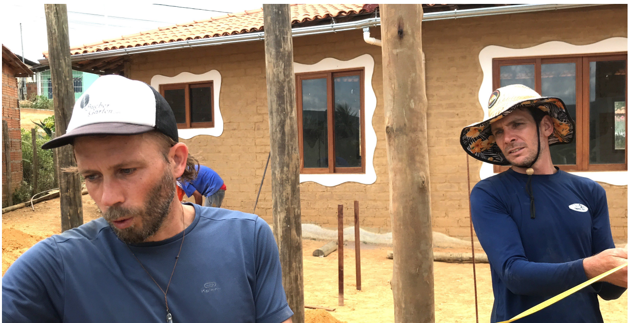
Bau der „Arcademia“: Rico und Stefan messen die Distanz der Holzpfiler aus.
