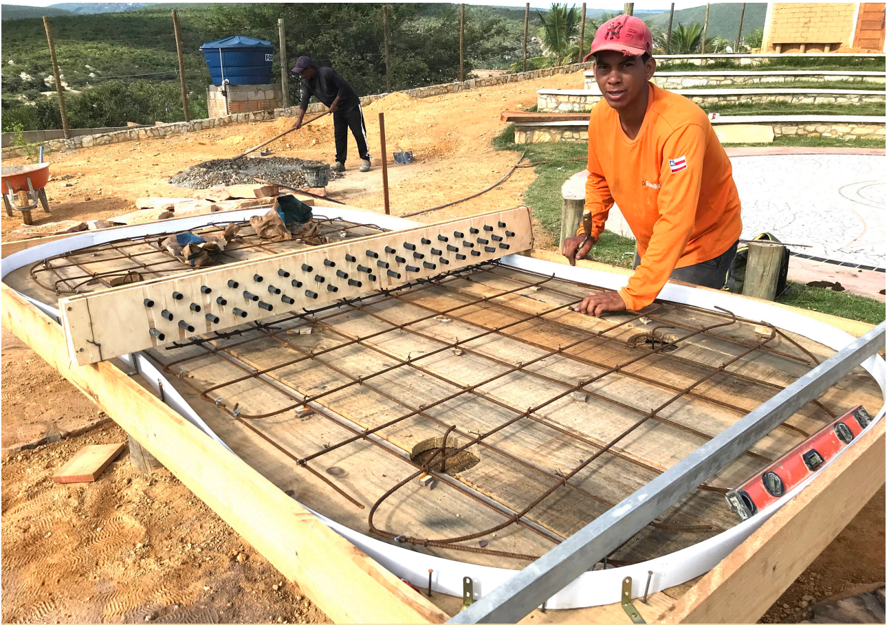
Diogo fixiert die Eisenstruktur des Pingpong-Tisches kurz vor dessen Betonierung.
