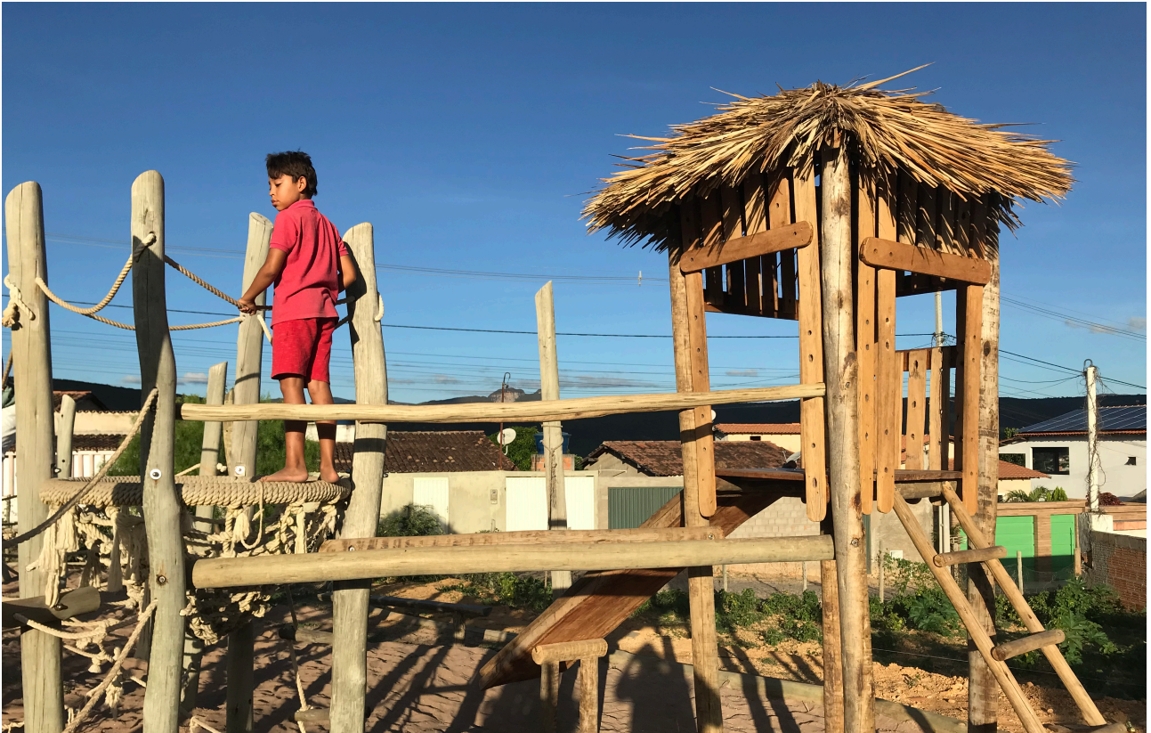
Fertiggestellt und verbunden mit dem restlichen Spielplatz: Der Rutschurm.
