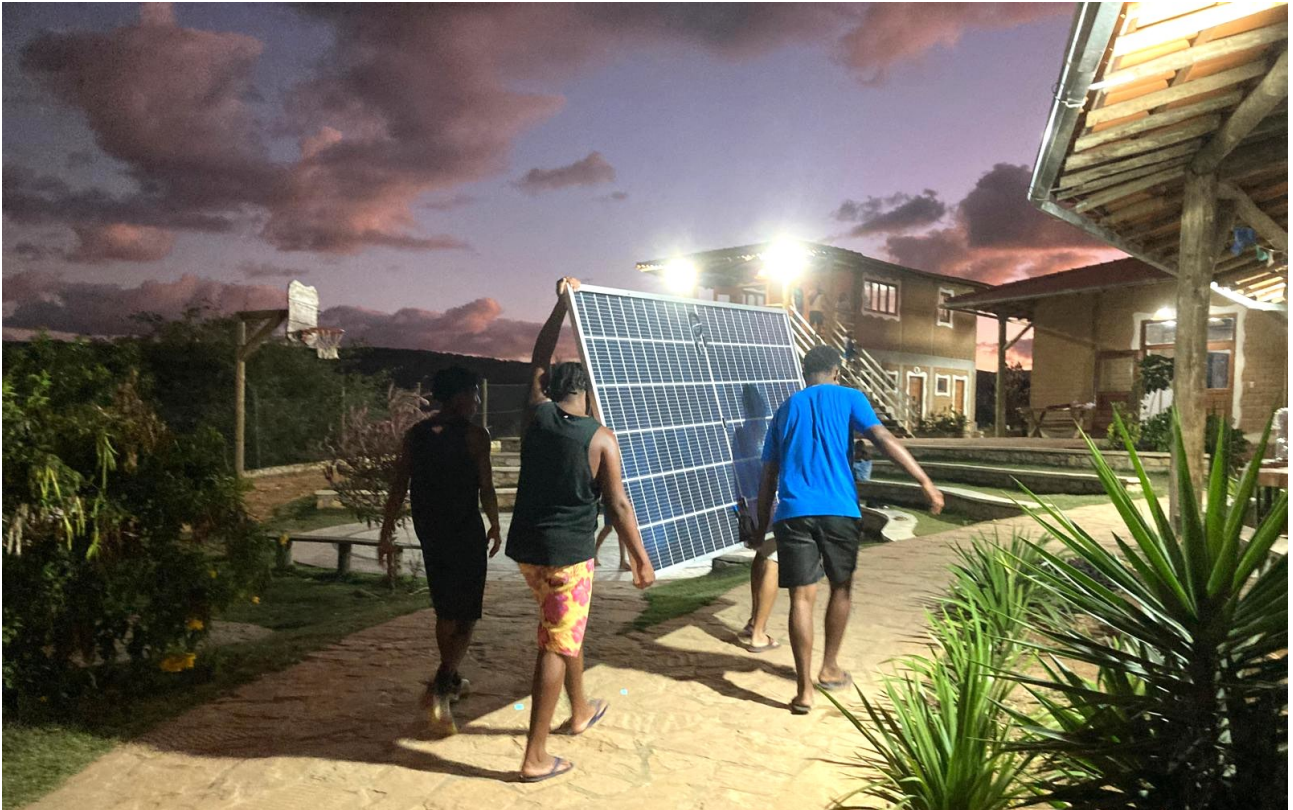
Juli 2024: Die Solarpanels werden geliefert und in Sicherheit gebracht.
