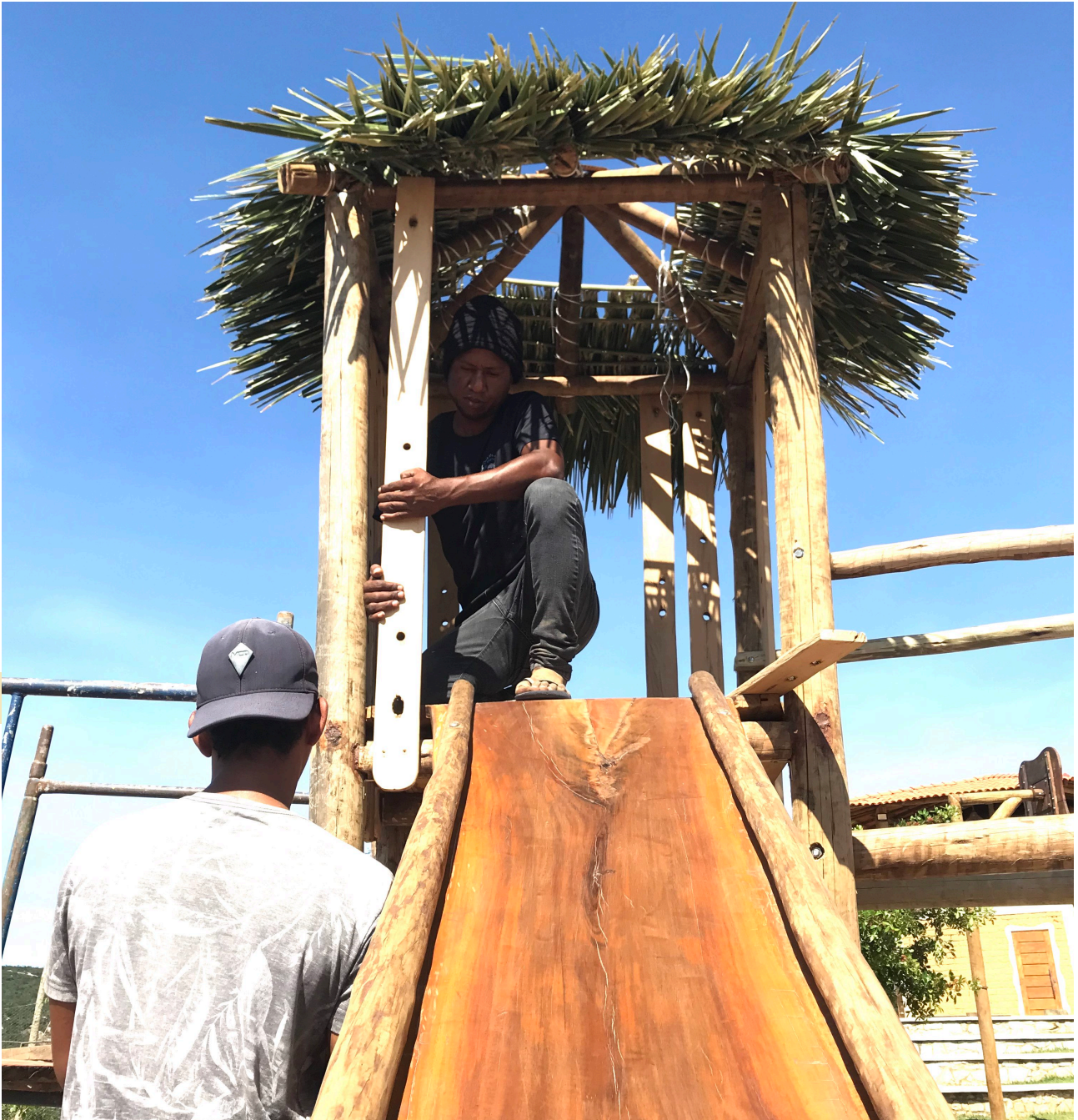
Diogo und Negassa montieren die Seitenwände aus Recycling-Holz.
